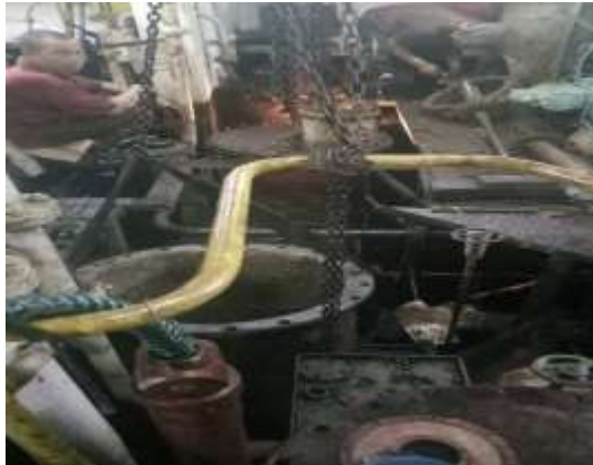
Gambar 4. 6 Proses repair high dan low sea chest pada dry dock
