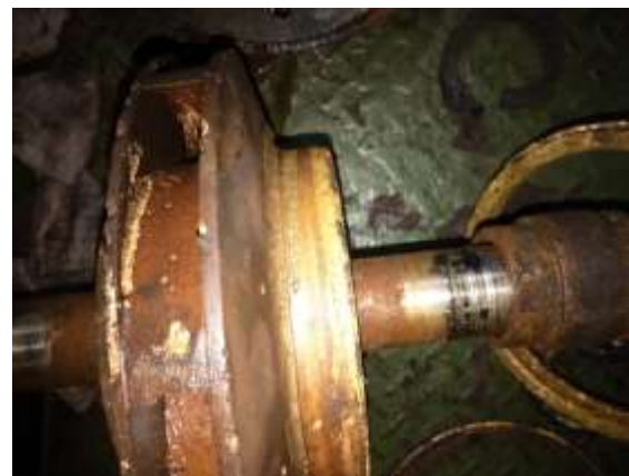
Gambar 4. 7 Penggantian impeler pada pompa sea water cooling
