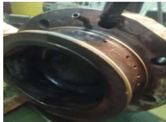
Gambar 4. 10 O-Ring yang di ganti pada Jacked Cooling Cyl no. 7
