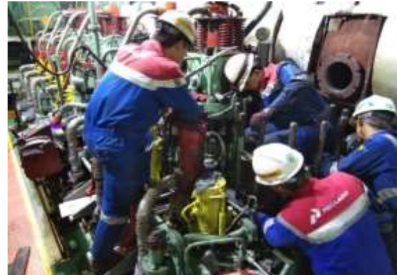
Gambar 4. 9 Proses pergantian O-ring pada jacked cooling mesin utama
